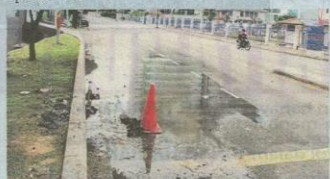
Kebocoran paip yang belum dibaik pulih dan menyebabkan kawasan sekitar kotor dan berbau busuk sewaktu tinjauan Sinar Harian .
